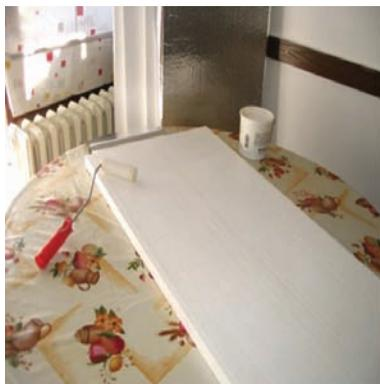
U prednjem planu je ploča stiropora pripremljena za nanošenje ljepila, a okomito u pozadini je ploča s već zalijepljenom folijom. Sama izrada je toliko jednostavna i čista da se može obaviti i u stambenom prostoru.
